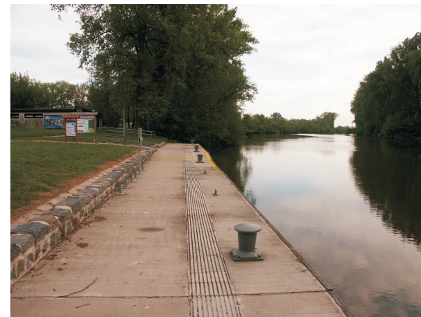
foto č. 21 pohled na stávající přístaviště Napajedla - Pahrbek na řece Moravě - jižním směrem; vpravo řeka Morava
