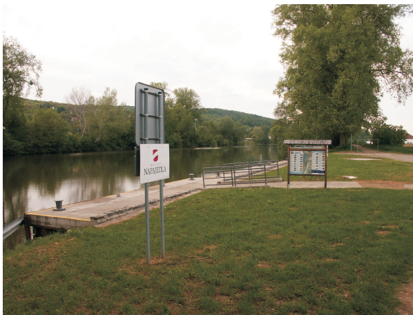
foto č. 20 pohled na stávající přístaviště Napajedla - Pahrbek na řece Moravě, cca 150 m od rekreačního areálu Pahrbek
