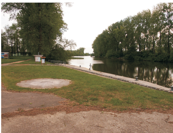
foto č. 23 pohled na stávající přístaviště Napajedla - Pahrbek
